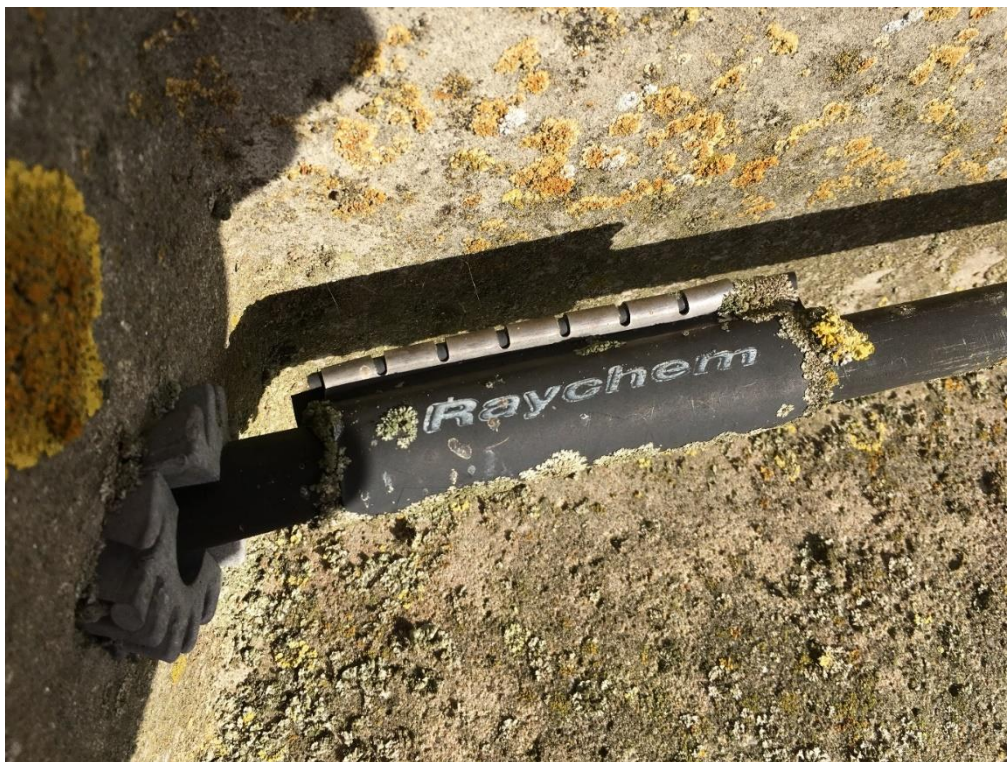
Foto 12. Eksempel på reparation ved anvendelse af krympeflex/lynlås muffe.
