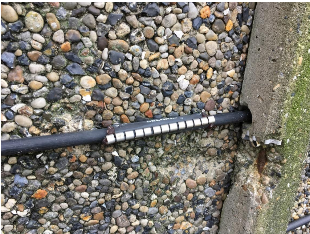
Foto 11. Eksempel på reparation ved anvendelse af krympeflex/lynslås muffe.
