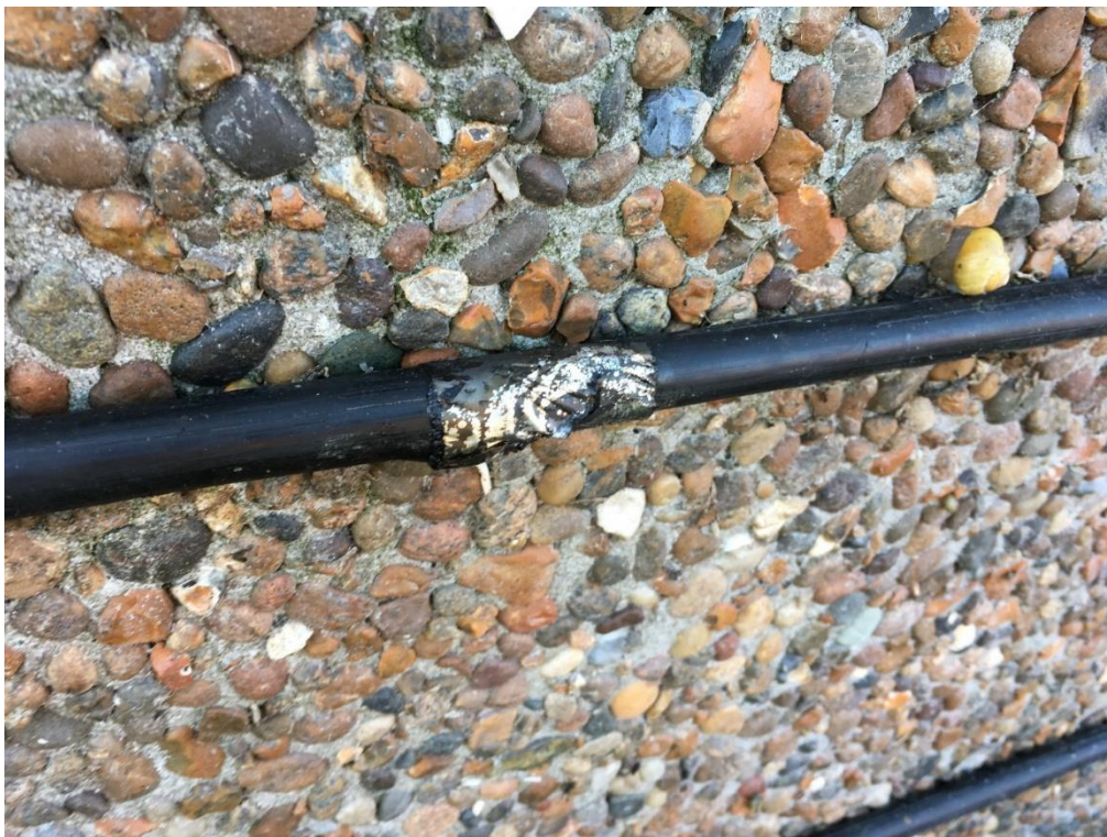
Foto 9: Eksempel på reparation med bitumenbaseret tape.
