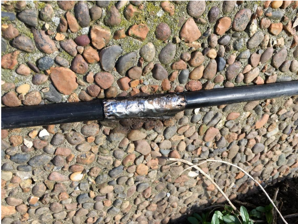
Foto 8: Eksempel på reparation med bitumenbaseret tape.
