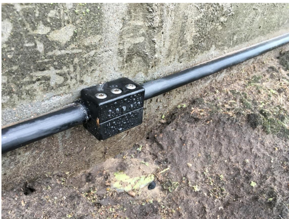
Foto 5: Eksempel på reparation af kabelbeskyttelse på Spæncom beholder, som forekommer at have den fornødne ydeevne og holdbarhed.
