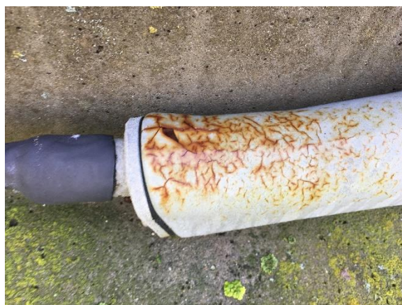
Foto 22. Større grad af overfladerust og revner i låsens overfladebehandling.
