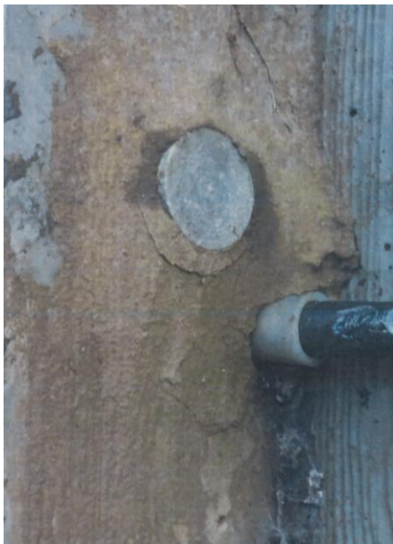
Foto 25. Indstøbt forankring/lås.
