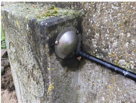
Foto 13. Afdækning på Spæncom beholder i form af ståldæksling med pakning.
