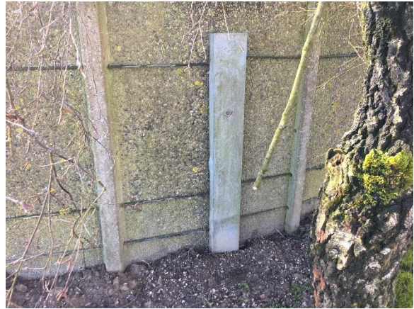
Foto 33. Afdækning af låse med stålskinne.
