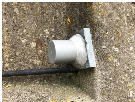
Foto 10. Afdækning på Perstrup beholder i form af plasthætte som sættes i en fugemasse. Stålbladen er galvaniseret.
