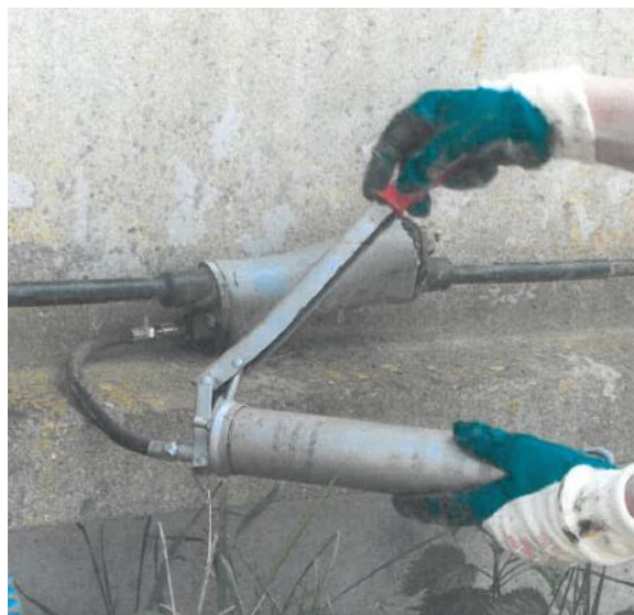
Foto 20. Efterfyldning af Dywidag lås med fedt.
