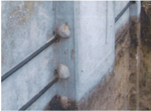
Foto 26. Indstøbt forankring
