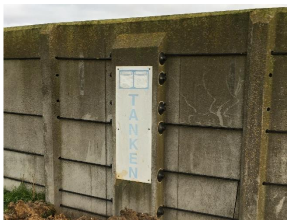
Foto 12. Afdækning på RC-tank i form af en plastkappe sat i fugemasse.
