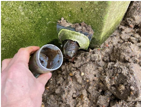
Foto 17. Afdækning på Perstrup beholder, hvor fugemassen er udtjent og der ses vand stående i hættet.
