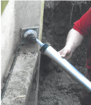
Foto 4. Påføring af fugemasse til afdækning på Perstrup beholder.
