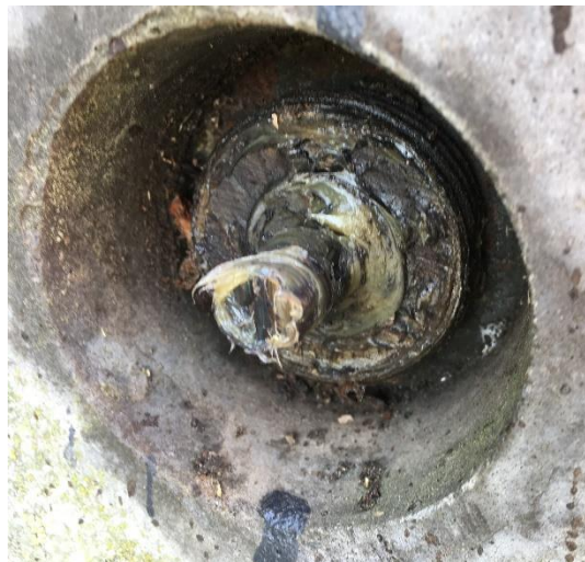
Foto 7. Kabellås med afmonteret plastafdækning med gevind. Fedtfyldt omkring kabel og lås.
