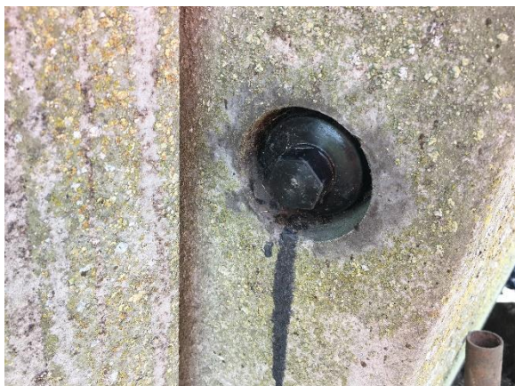
Foto 9. Afdækning på Agri beholder i form af plastkappe med gevind.
