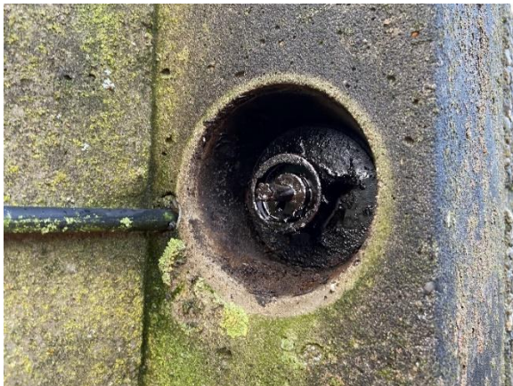
Foto 27. Lås på Muleby beholder med dækkende overfladebehandling.
