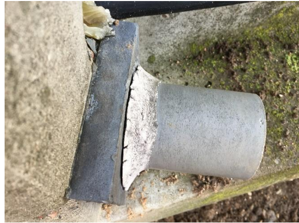
Foto 16. Afdækning på Perstrup beholder, hvor fugemassen er udtjent og der ses fugeslip til stålpladen.
