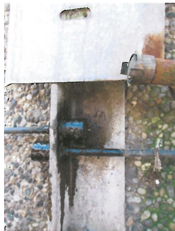
Foto 28. Låse afdækket og smurt med korrosionsbeskyttelse.
