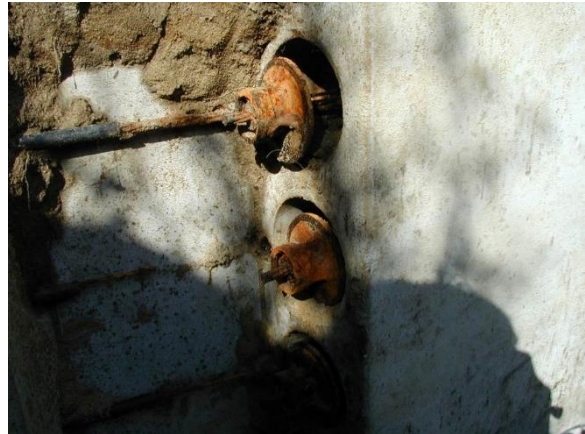
Foto 30. Låse hvor der ses korrosion på låsehuse og ingen overfladebehandling.
