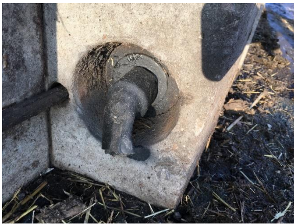
Foto 5. Alternative afdækninger end de oprindelige, her i form af en krympeflex, sat ud over låsehuset, anbefales ikke.
