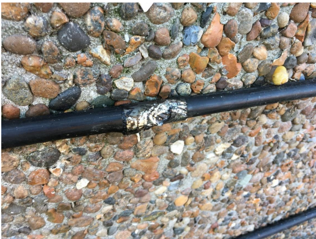
Foto 9: Eksempel på reparation med bitumenbaseret tape.
