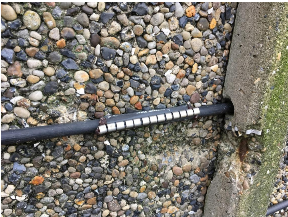
Foto 11. Eksempel på reparation ved anvendelse af krympeflex/lynlås muffe.
