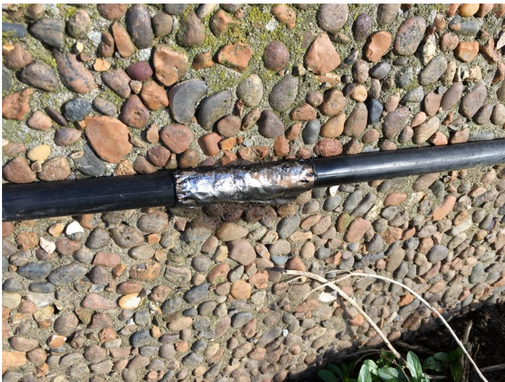
Foto 8: Eksempel på reparation med bitumenbaseret tape.
